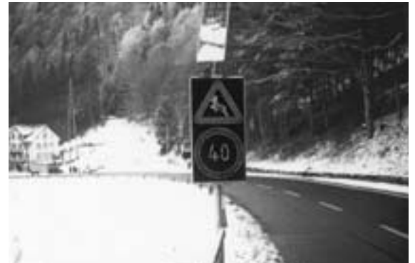
Fig. 4 : exemple à l'étranger d'un système d'avertisseur électronique annonçant un danger, associé à une limitation de vitesse.
