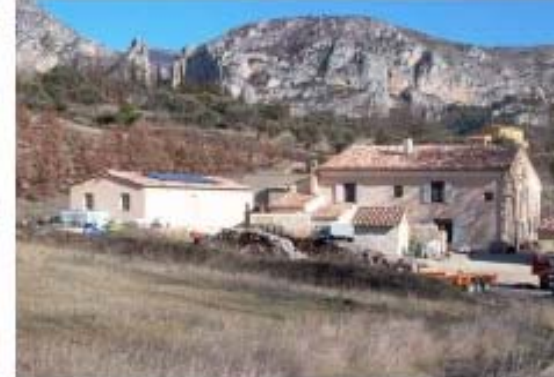
Panneaux solaires en surimposition : l'impact aurait pu être plus faible en intégration totale dans la toiture
