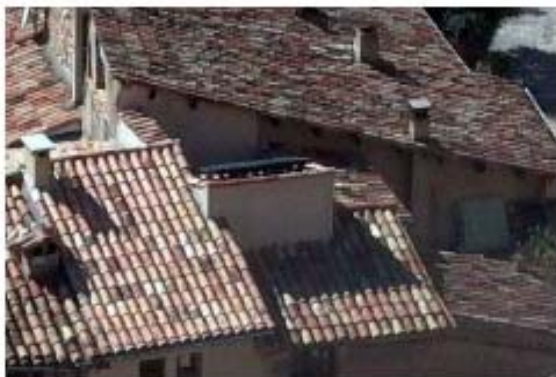
Panneau solaire thermique dans le vieux village : une intégration exemplaire
