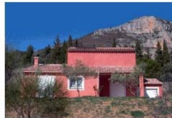
Panneau solaire en surimposition, peu visible depuis le sol (chemin public en contrebas)
