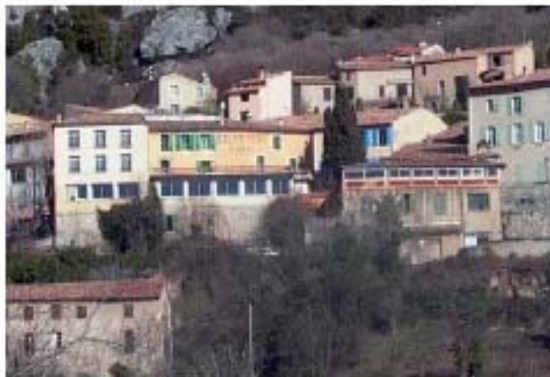
Bandeaux vitrés sur la façade du village, pouvant s'assimiler à des panneaux solaires
