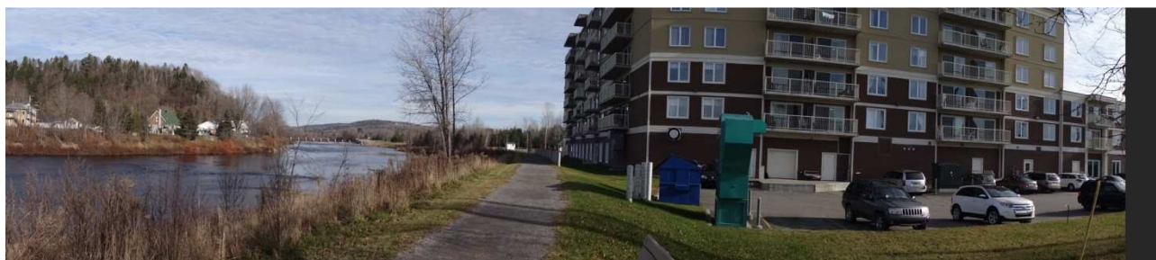
Figure 5 : la résidence pour personnes âgées de l'Estacade côté rivière - © COPARI
