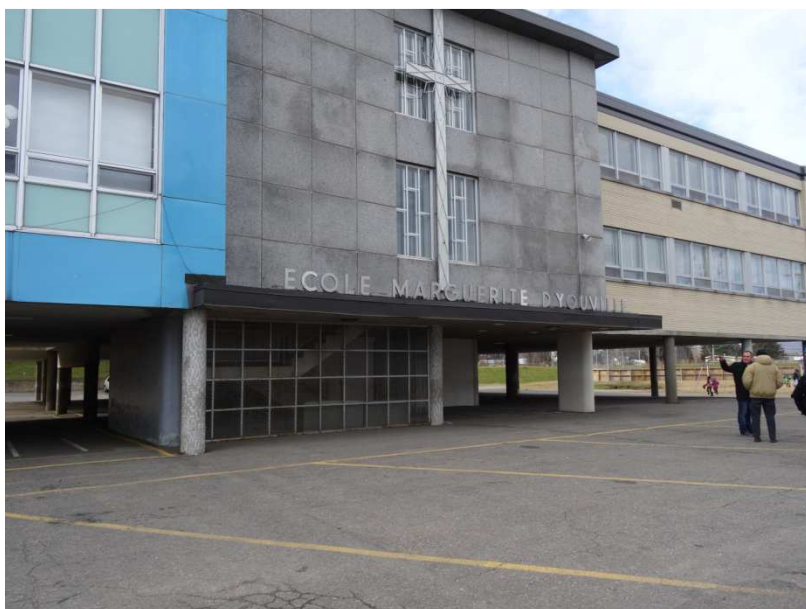
Figure 4 : l'école de Saint Raymond, construite sur pilotis © COPARI
