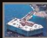
→ Ouvrages portuaires p.04
