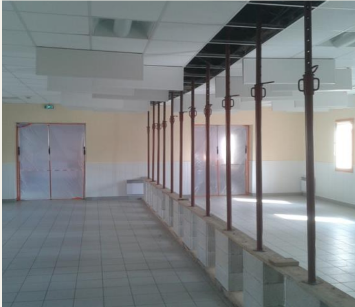
Affaissement de la charpente – fuites d'eau
