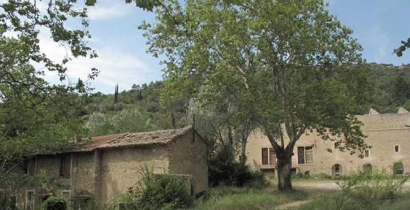
LES PATRIERES – Les bâtiments existants
