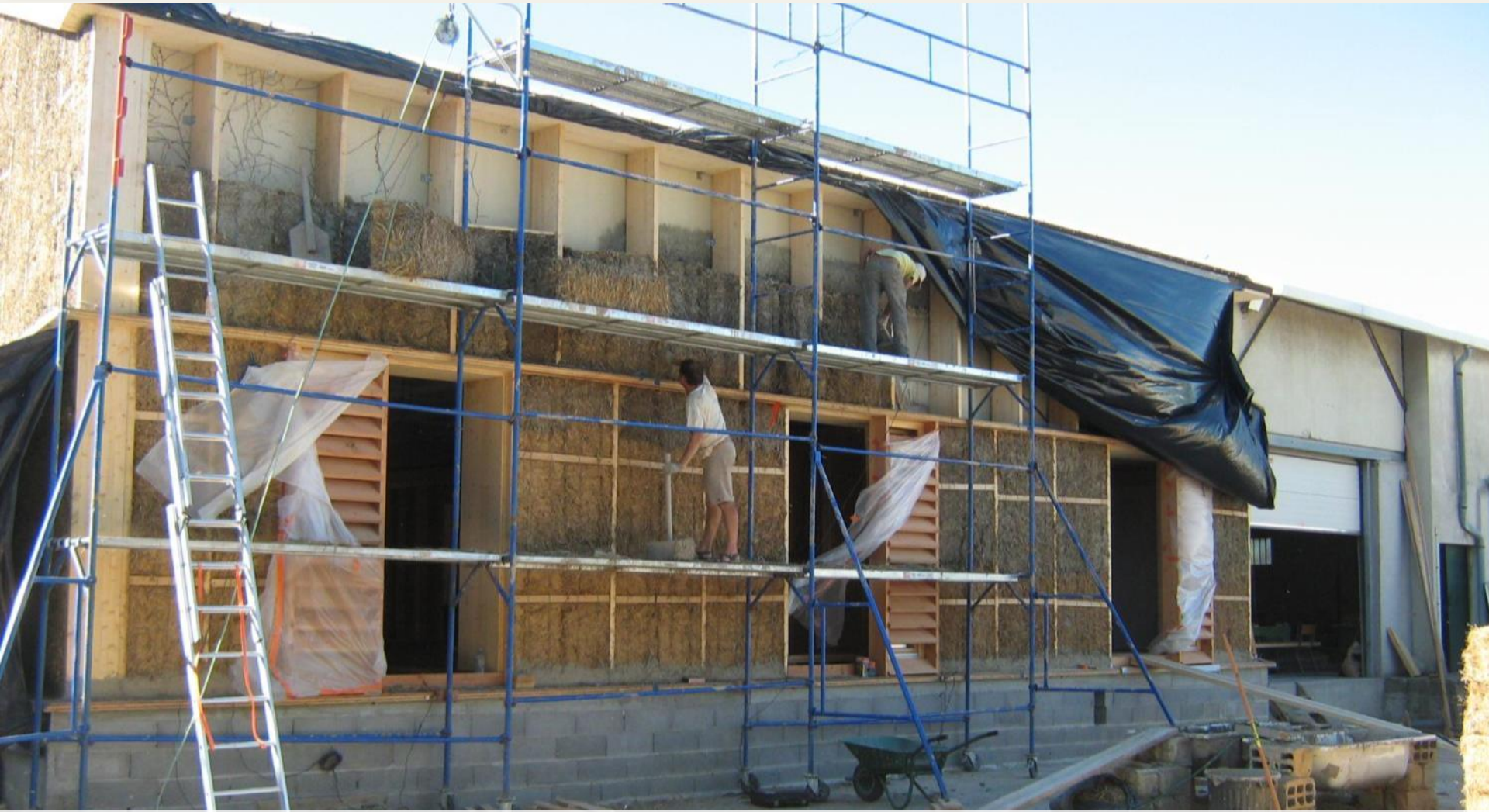
Ecole Montessori – Le chantier paille
