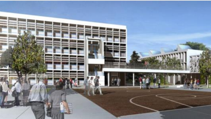
Façades Sud et Ouest – Lycée Audiberti
