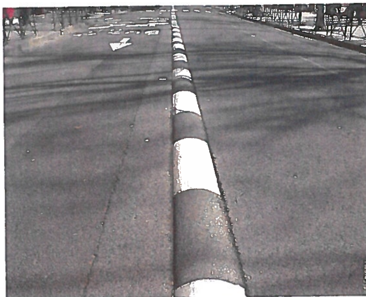
Séparateur de type bourrelet de protection du couloir bus franchissable (6-7 centimètres).
