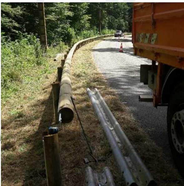
Nouvelle glissière mixte bois-métal, niveau de retenue N2 (V= 90Km/h) et équipée d'un écran-moto
