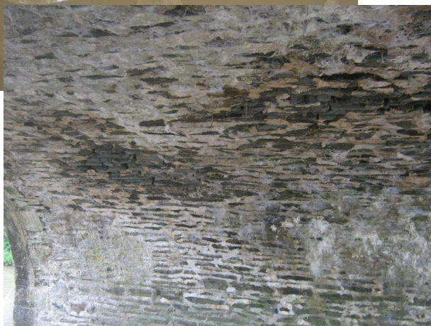
Dégarnissage des joints
