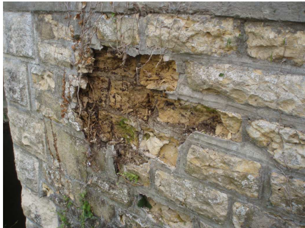
Dégradations de pierres suite à un rejointoiement au mortier de ciment et aux cycles gel / dégel
