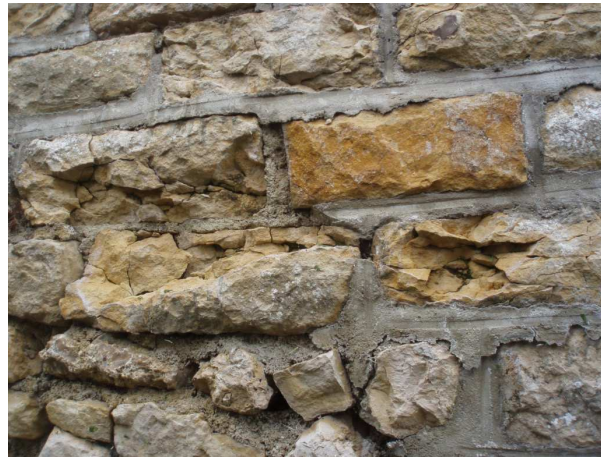
Dégradations de pierres suite à un rejointoiement au mortier de ciment et aux cycles gel / dégel
