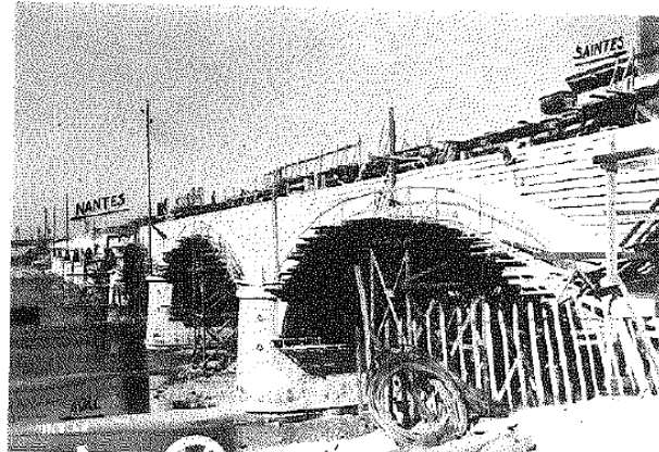
Reconstruction des 3 arches sur cintres en rails.
