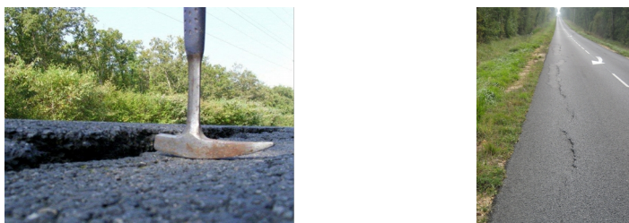
Figure 12. Exemple de pathologies de chaussées liées au retrait-gonflement
