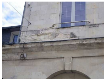
Habillage en zinc
