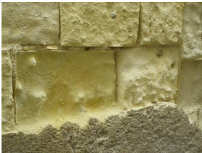
Mise en œuvre d'un enduit ciment
