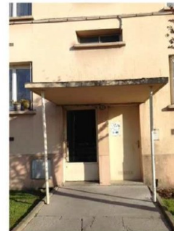
Vue extérieure. Etat des lieux.
