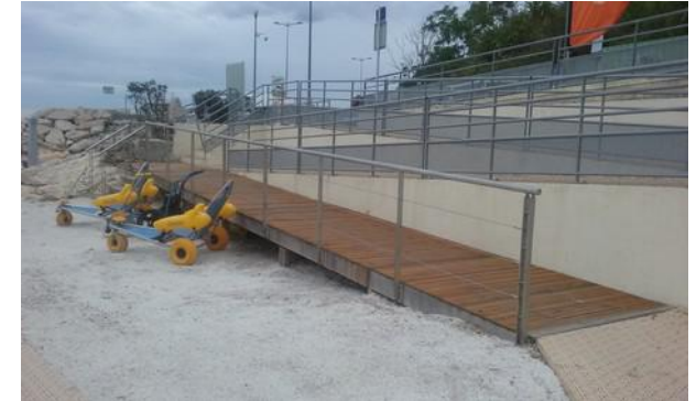
Accès PMR à la plage
