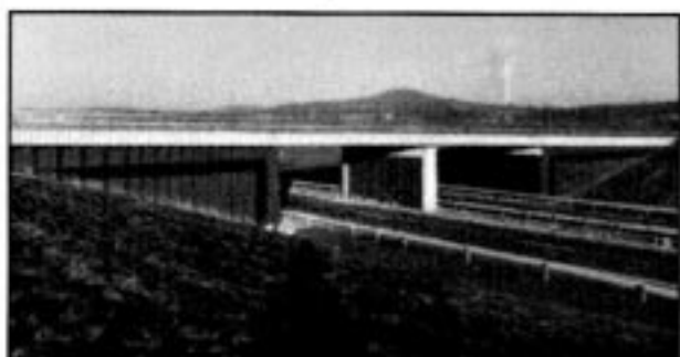
A31 CA4 - Entreprise PERTUY
