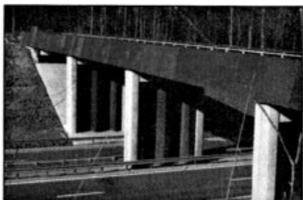
A31 Continuité autoroutière OAS - Entreprises DIETSCH et DURMEYER
