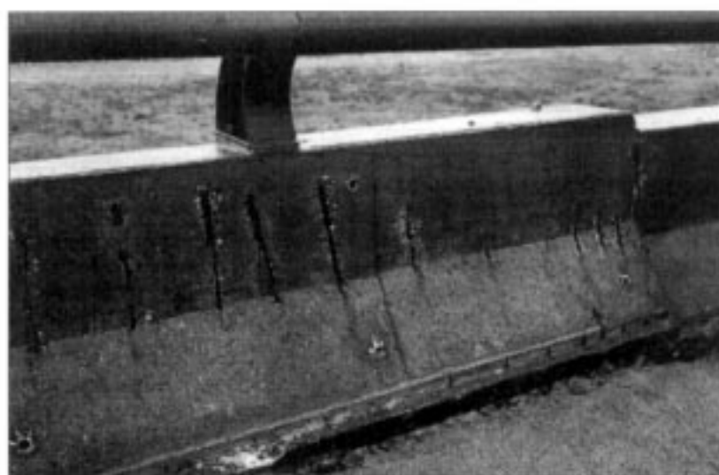
Mise en œuvre sur un trottoir du pont de Gilly (A 43)
