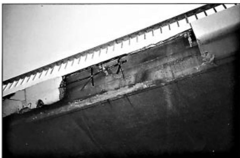
Dégâts occasionnés sur la corniche par un véhicule hors gabarit.
