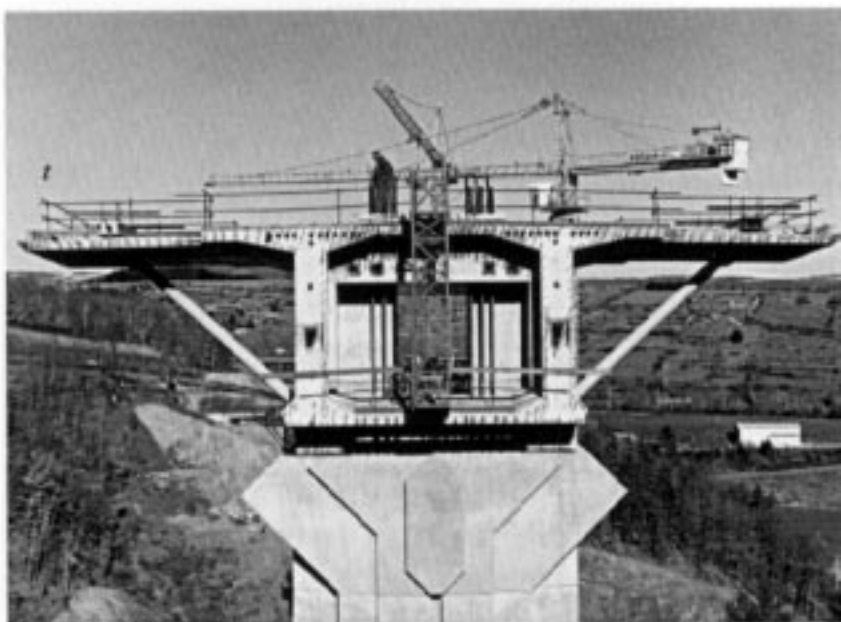
Viaduc du Piou - Tablier béton
