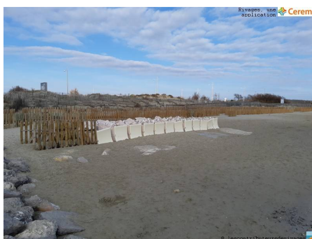
Modules de Wave Bumper installés à Carnon Source : Application Rivages, Cerema, 2019
