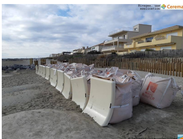
Modules de Wave Bumper installés à Carnon Source : Application Rivages, Cerema, 2019
