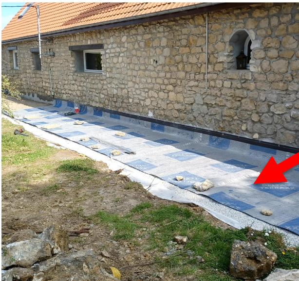
**Une membrane imperméable**
