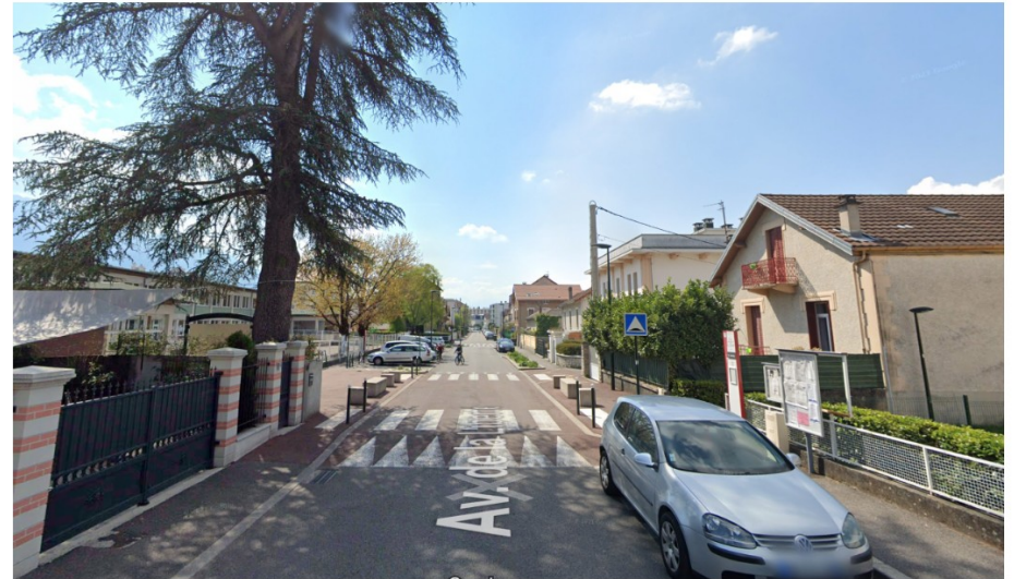
Photo Avenue de la Liberté - Aix les Bains - avril 2021 - Street View
