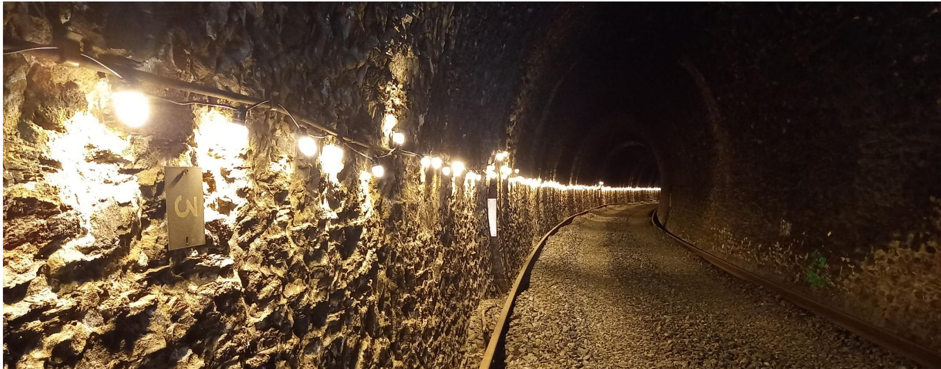
Chantier de renouvellement sur la ligne du Cévenol, à Chamborigaud (Gard), avec des matériaux de réemploi et moyens légers, ce qui réduit le coût fixe – B. Meignien, Cerema 2022
