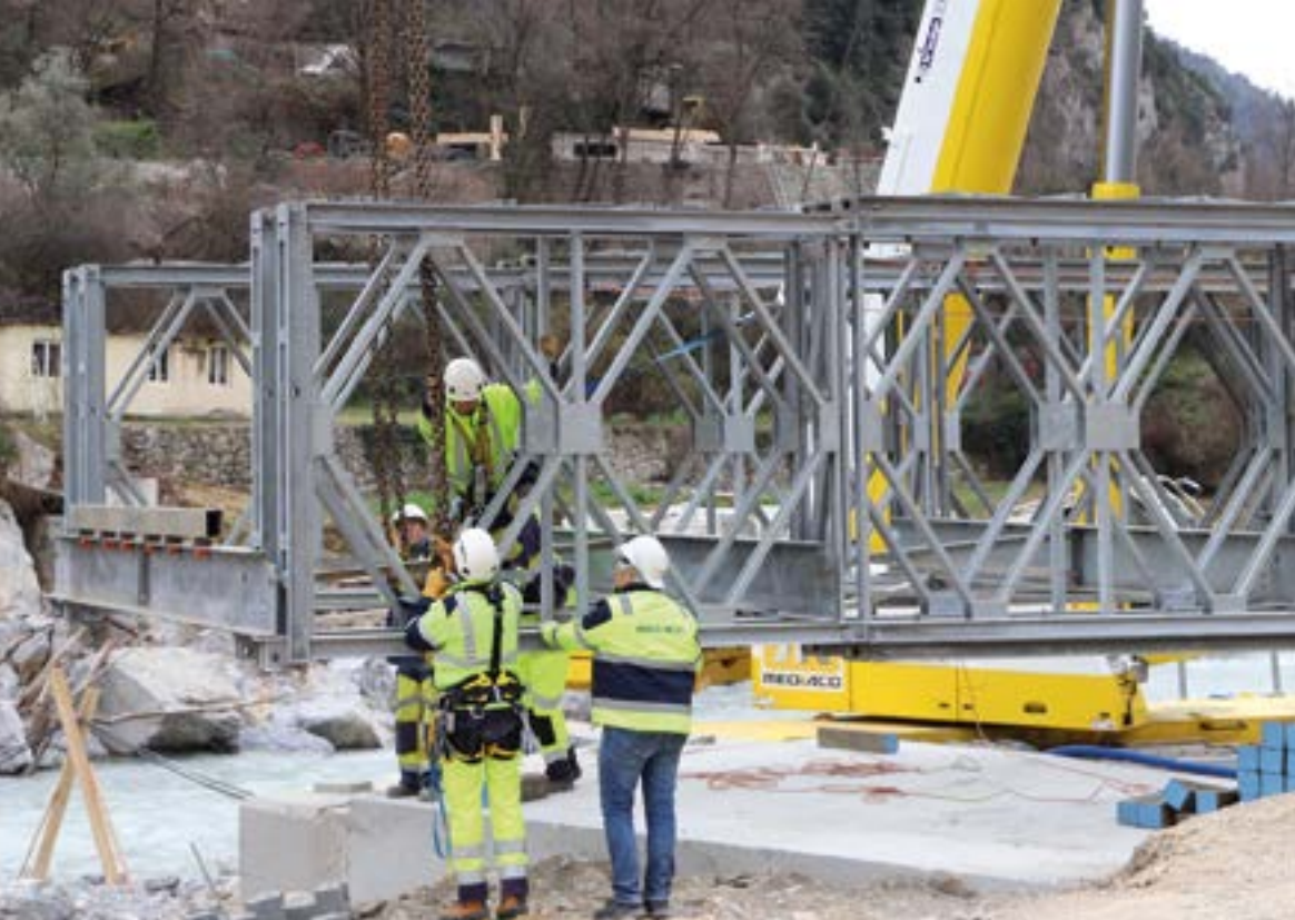
Installation d'un pont provisoire en 2021 à Breil-sur-Roya, Alpes-Maritimes
