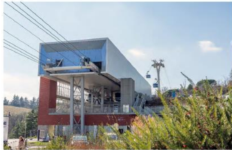
La station CHU sur Téléo : les piliers renferment les ascenseurs d'accès ©Tisséo.
