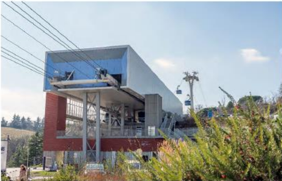
La station CHU sur Téléo : les piliers renferment les ascenseurs d'accès ©Tisséo.
