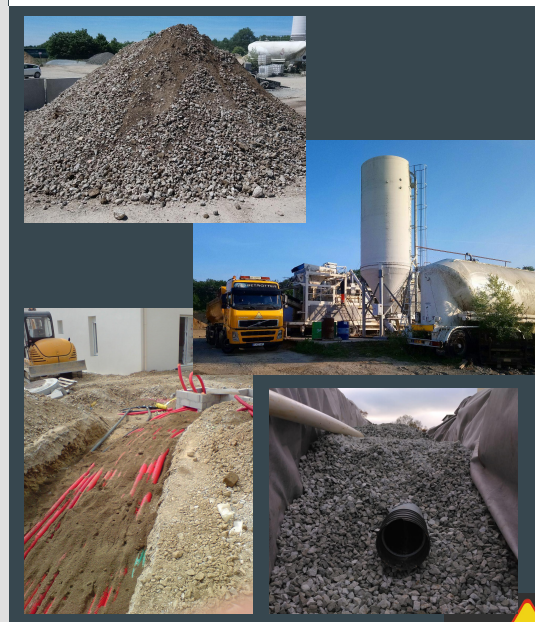
Mise en oeuvre des matériaux
