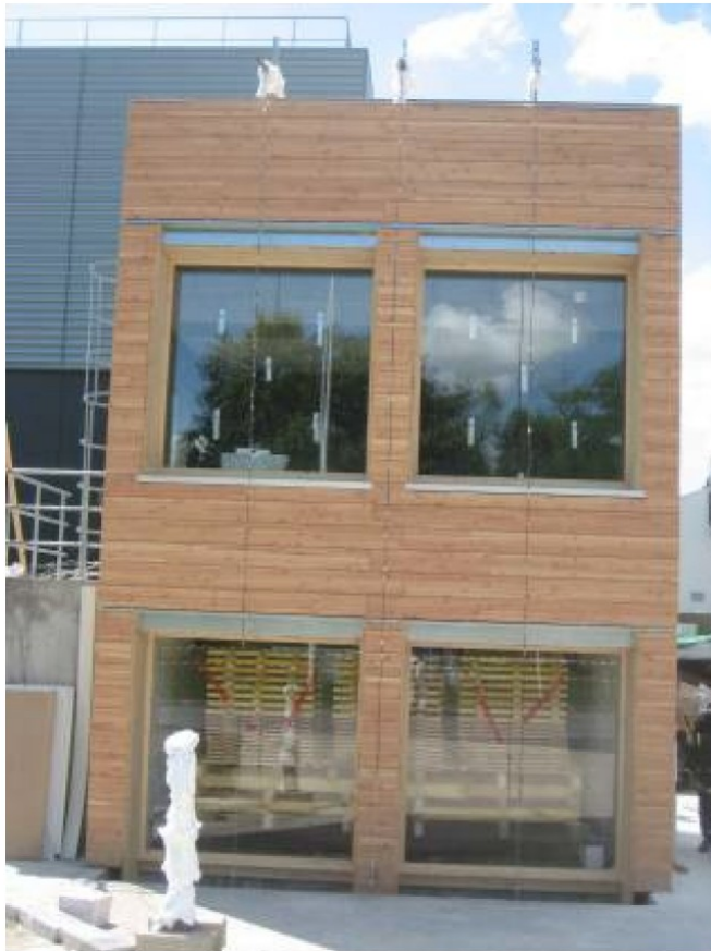
Vue de la façade à t = 0
