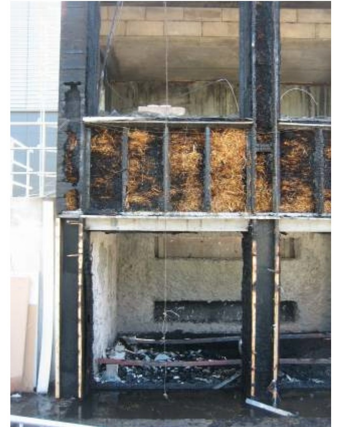
Vue de l'allège SUD après refroidissement
