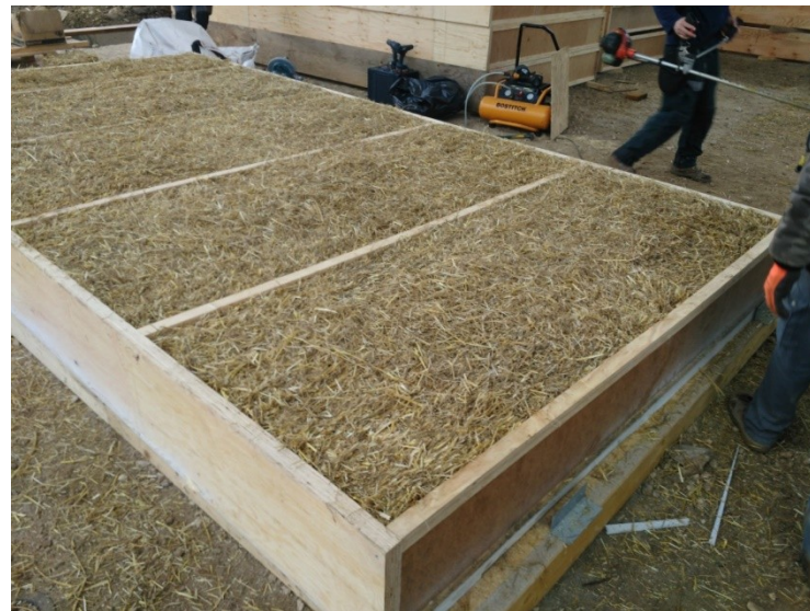
Matériau de construction
