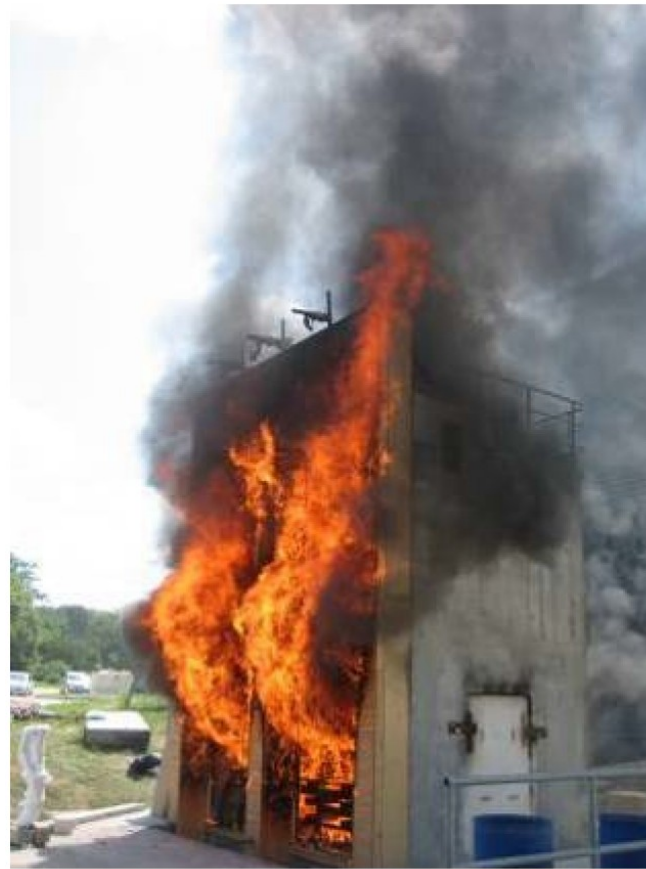
Vue de la façade à t = 2 min
