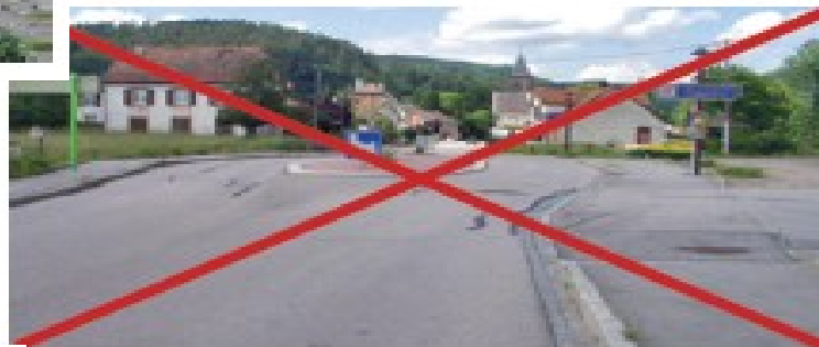
Exemple non réglementaire Îlot avec balise J5 non précédé d'une ligne continue
