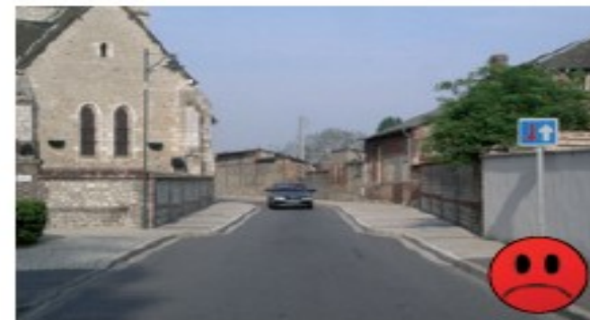
Ecluse trop proche d'un virage Manque de visibilité
