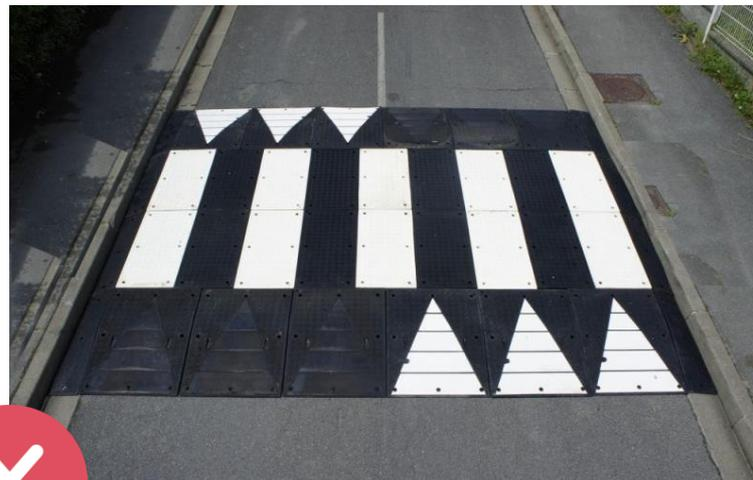
*Mélange de dos d'âne, de trapézoïdal et de plateau*
