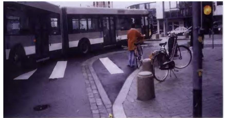
*Exemples de surlargeurs permettant la giration des véhicules longs en limitant l'évasement de l'intersection.*
