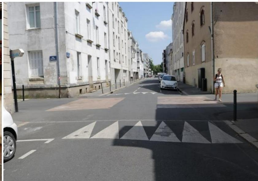
*Exemple d'élévation de la chaussée favorisant la modération de la vitesse dans l'intersection*
