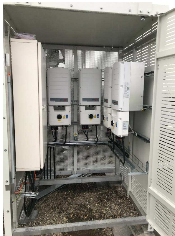
Shelter avec onduleurs et coffrets électriques
