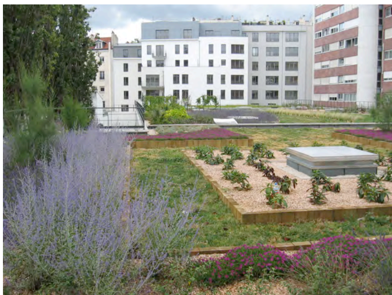
Figure 12 Végétalisation semi- intensive sur une résidence à Boulogne- Billancourt (92) (CD92)
