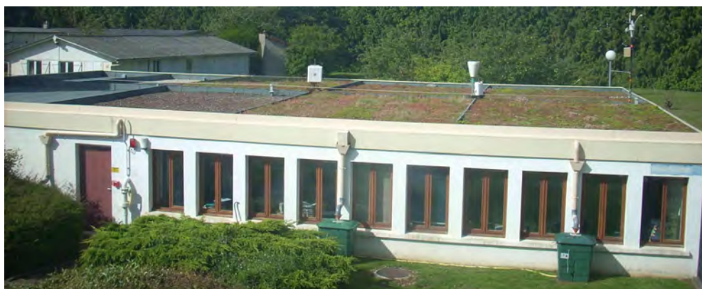
Figure 15 Vue de la toiture du CEREMA de Trappes, et des installations de suivi des différents types de couverture (source : TVGEP)
