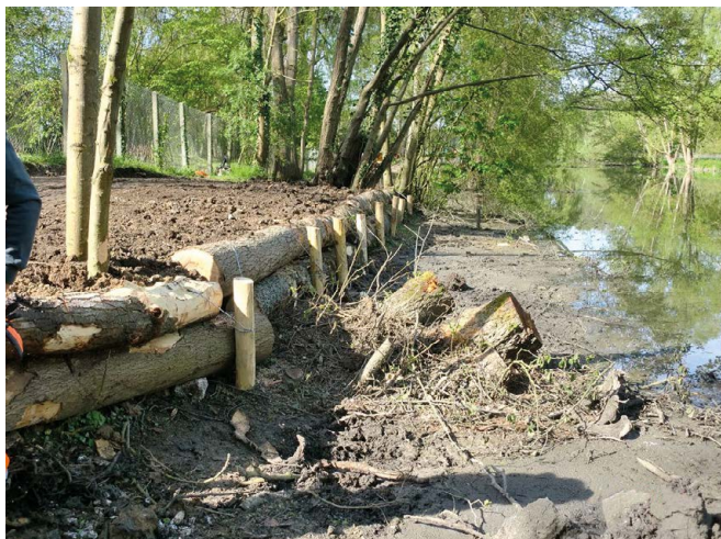
↑ Confortement de berges, à l'aide de troncs issus des abattages préalables, 2016, © F. BREHIER, TERIDEAL
