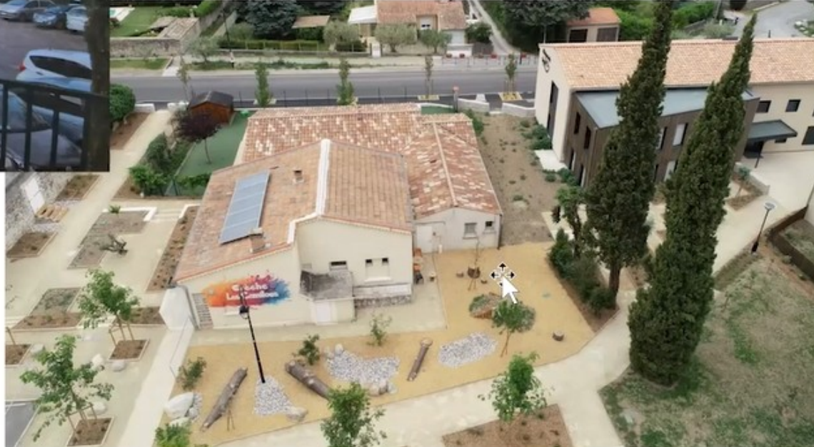
La réalisation (à la livraison)
