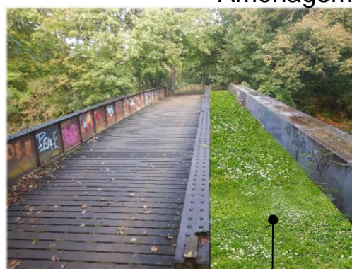
Banquette végétalisée au-dessus des canalisations
