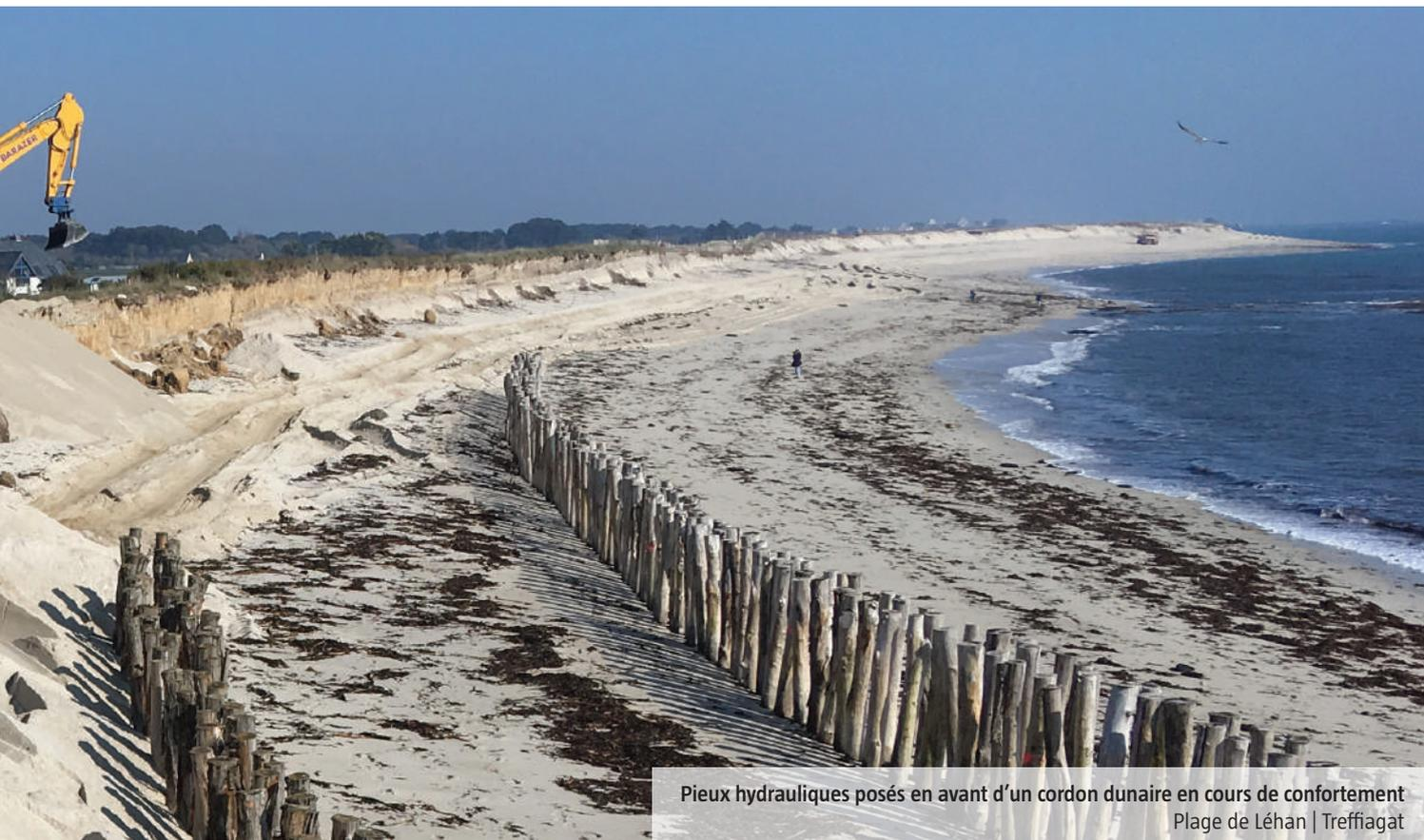
Pieux hydrauliques posés en avant d'un cordon dunaire en cours de confortement
