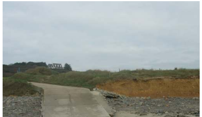
Figure 8-1 (b) : cale perpendiculaire au trait de côte entravant la dérive littorale des galets d'ouest en est, en haut de la plage de l'Aber de Crozon. A l'ouest (gauche de la photo), les galets s'accumulent en pied de falaise et la protègent comme en témoigne la végétation qui couvre sa paroi ; à l'est (droite de la photo, le volume de galets est moindre, la falaise est en érosion (absence de végétation, paroi ravivée). Vue prise vers le nord, novembre 2006.
