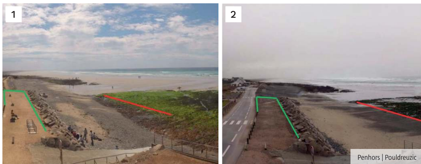
Figure 9-4 : variation du niveau de sable au droit d'un enrochement sur la plage de Penhors à Pouldreuzic. Photo 1 : juin 2022 / photo 2 : décembre 2022. Les traits verts servent au calage des deux images. Le trait rouge montre la variation du niveau de sable entre les deux clichés.
