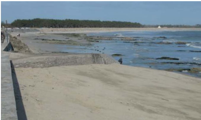
Figure 8-1 (a) : obstruction au passage des sédiments par une cale d'accès à la plage de Mousterlin. Notez l'accumulation de sable en amont-dérive (premier plan), l'élévation du niveau du sable le long du mur et la faible hauteur de la plage en aval-dérive (au-delà de la cale) où le mur a dû être renforcé par un enrochement. Vue prise vers le nord-est, mars 2007.
