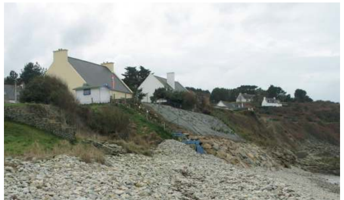
Figure 8-1 (d) : effet de la réflexion des vagues sur l'ouvrage en enrochements. Le niveau du sommet du cordon de galets est nettement plus élevé là où le trait de côte n'a pas été artificialisé ; au contraire, devant l'ouvrage, l'altitude du cordon et le volume de galets sont nettement moindres. Plage du Moulin-de-la-Rive à Locquirec, février 2010. Vue prise vers l'ouest.
