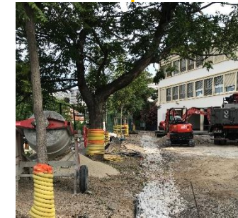
6. Chantier de la cour en été
