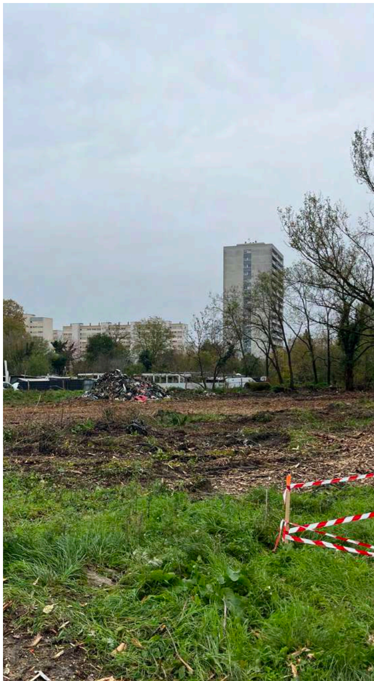
11/22 - LANCEMENT DE CHANTIER
