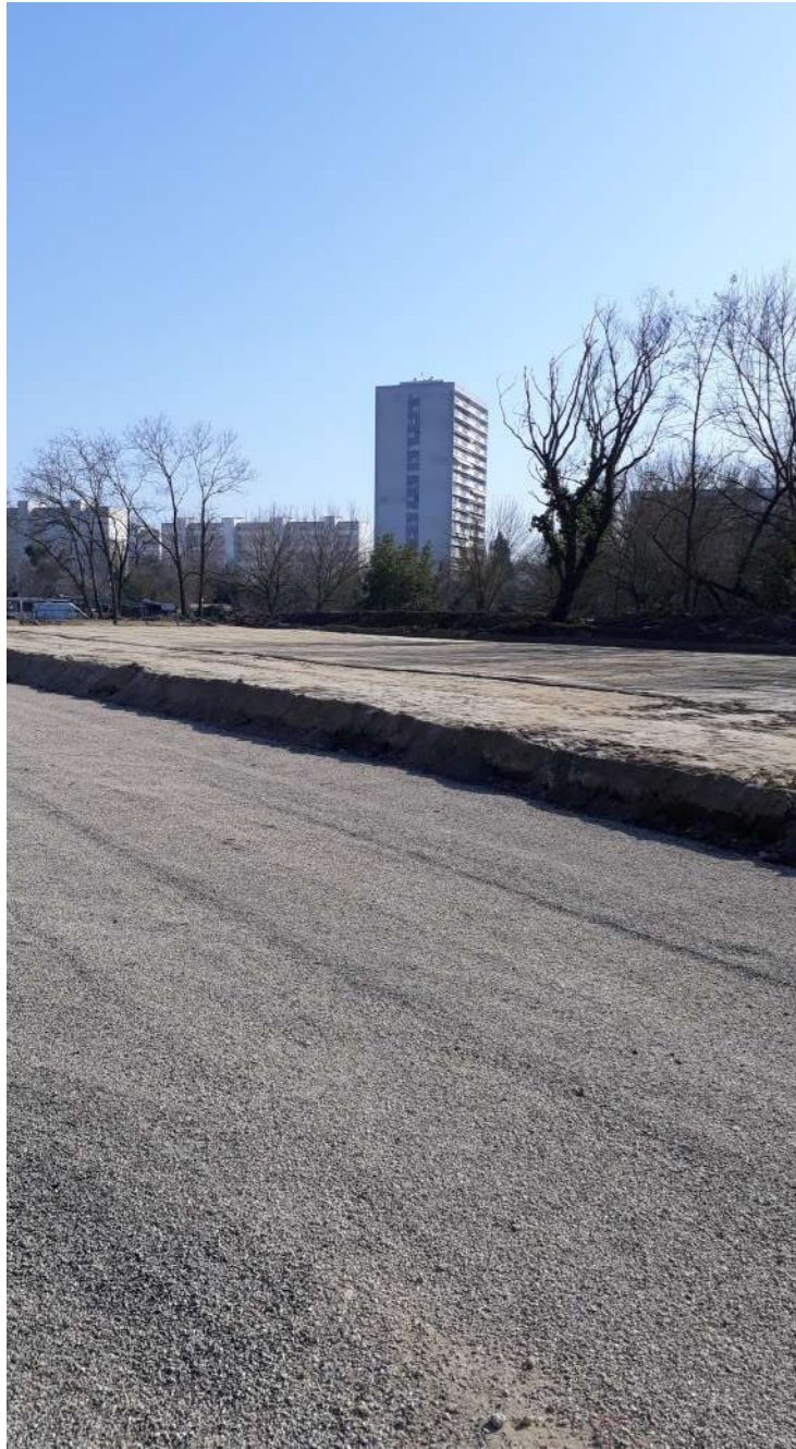
02/23 - ENDUIT SUR VOIRIE
