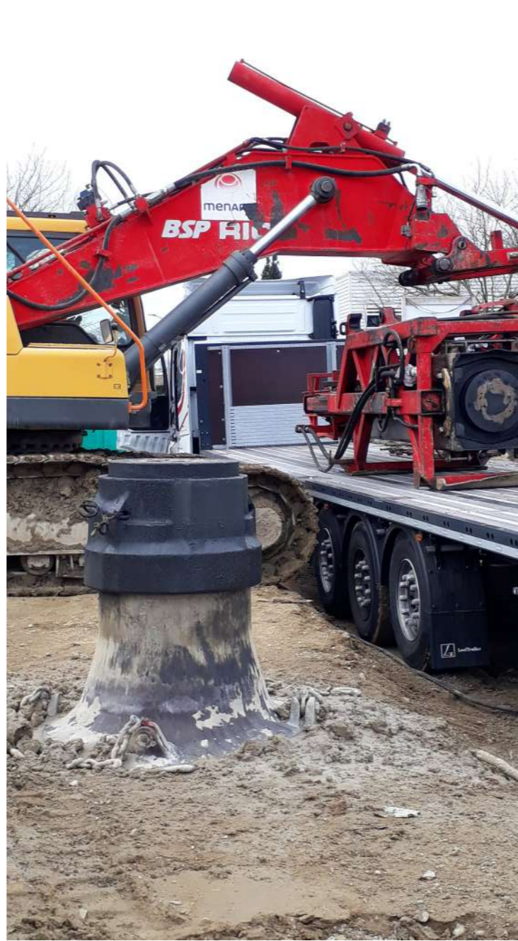
03/23 - COMPACTAGE PAR IMPACTS RAPIDES
