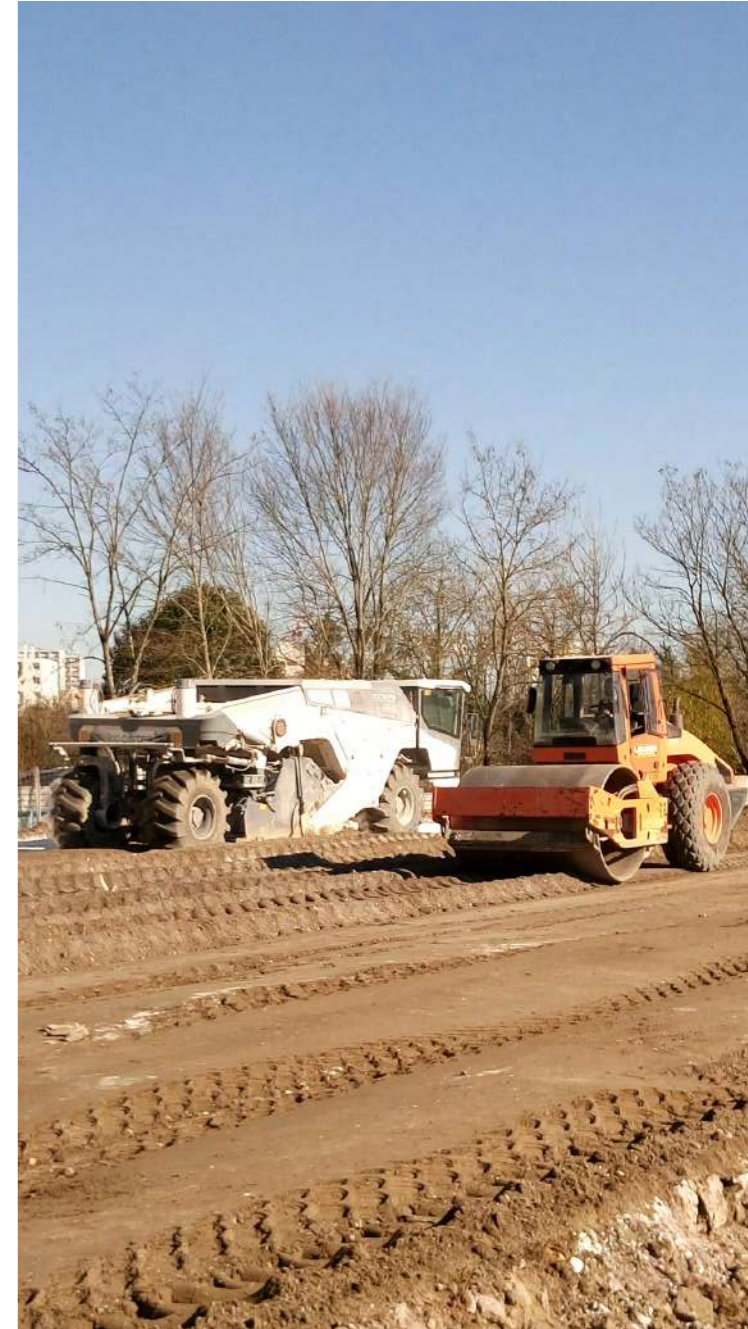
02/23 - TRAITEMENT A LA CHAUX
