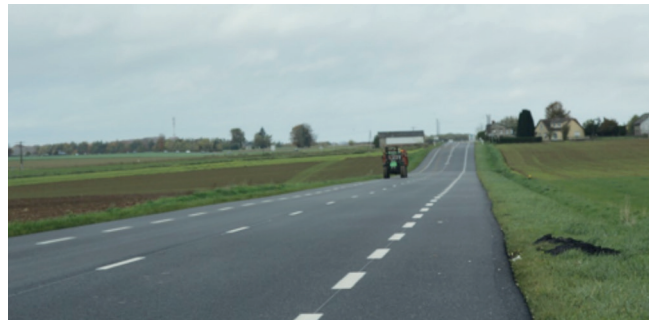
Exemple d'utilisation d'un accotement revêtu par un engin agricole. Source : Cerema
