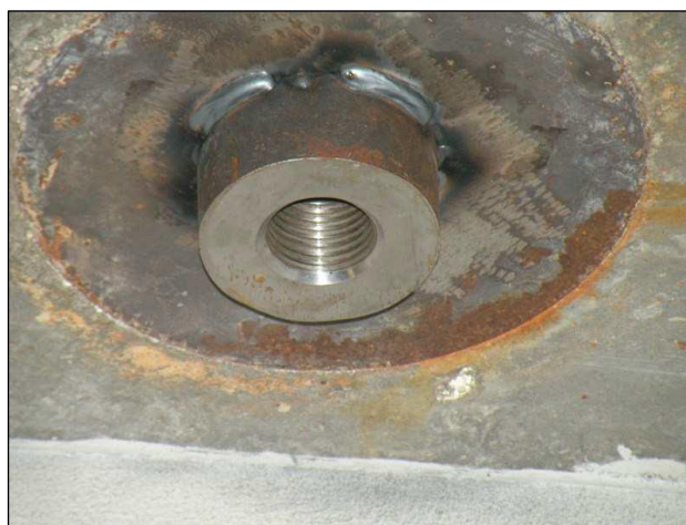
Figure n°14 : Exemple d'écrou soudé sous le puits
