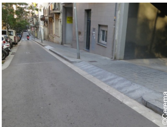
Illustration 21: Cheminement sans ressaut pour le piéton
