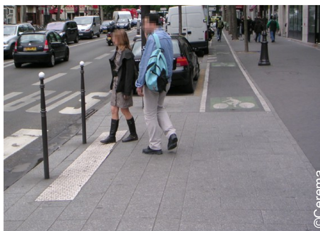
Illustration 29: Espace de cheminement plan en arrière de l'abaissé qui mène à la traversée
