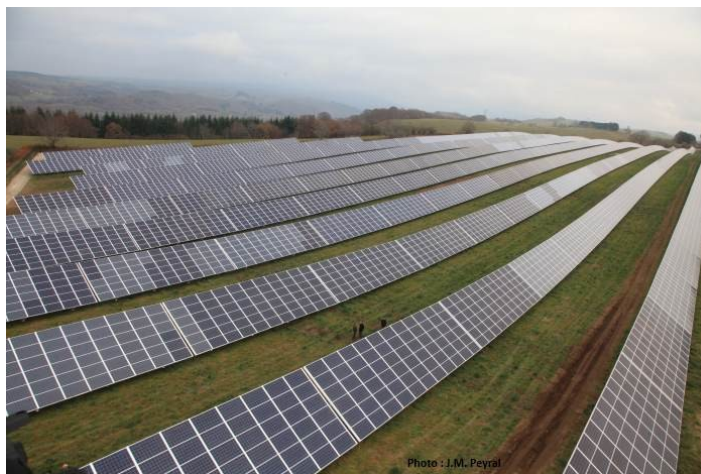
Illustration 2. Centrale solaire à Jussac (15) 19
