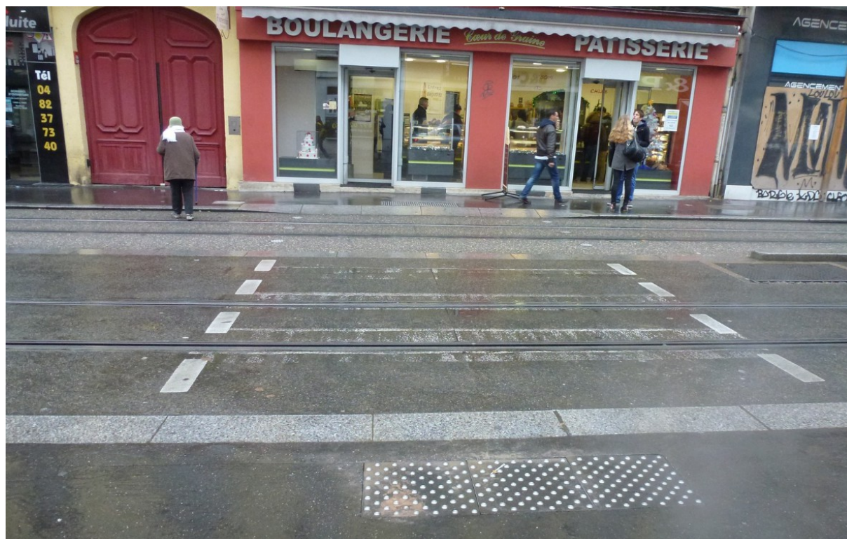
Site 56 : Au premier plan voie banalisée : les passages piétons ont été effacés, seuls demeurent des tiretés qui encadrent la traversée. Au second plan, voie en site propre : la traversée piétonne est matérialisée par des clous.
