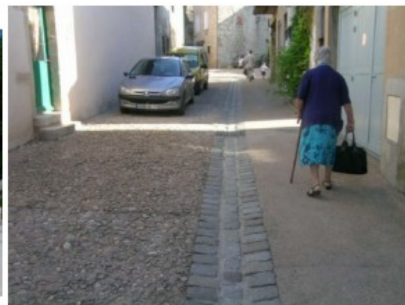
Les piétons se déplacent naturellement sur le revêtement le plus confortable (source : Cerema) ; ici le choix a été fait d'offrir aux piétons un revêtement différent pour identifier leur cheminement et aussi pour davantage de confort
