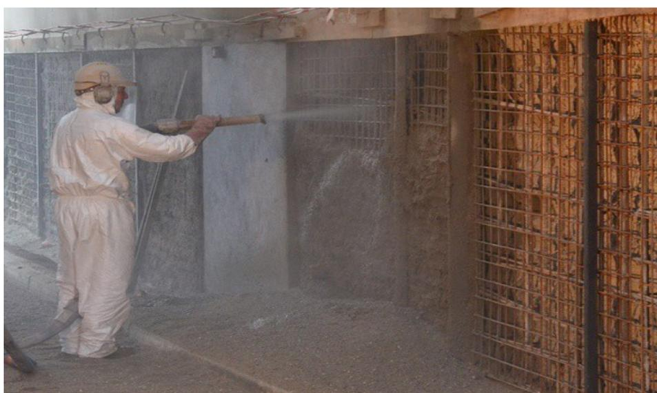
Illustration 1: Mise en œuvre de béton projeté par voie sèche
