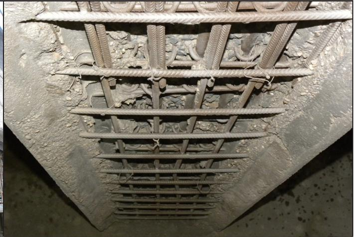
*Illustration 4: La même poutre après projection des faces latérales, avant projection de la sous-face*
