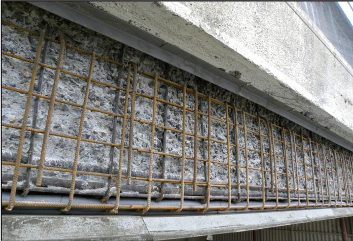
*Illustration 3: Poutre avec dispositif de coffrage des arêtes*
