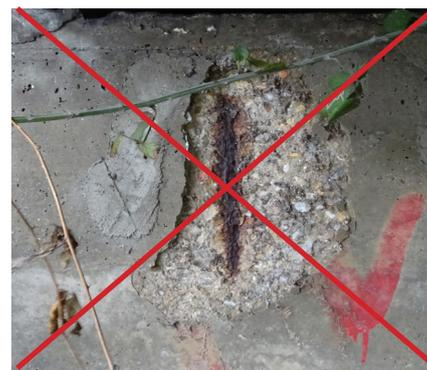
Cette technique est également parfois utilisée préalablement à la mise en œuvre des techniques de réhabilitations électro-chimiques (protections cathodiques par exemple) afin de traiter les zones de béton non cohésives.
