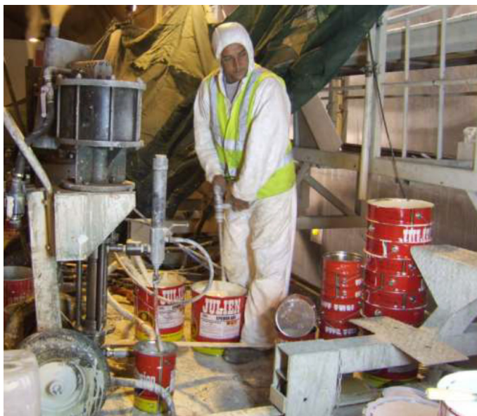
Illustration 3: Mélange avec un agitateur
