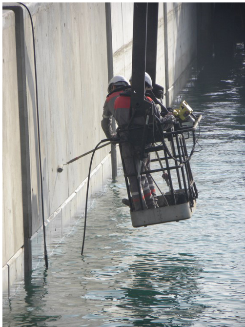
Illustration 4: Application d'un revêtement au rouleau
