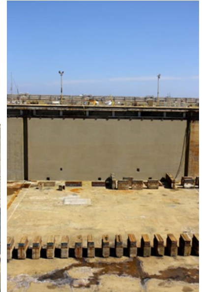
Après reconstitution du béton d'enrobage et application d'une protection de surface
