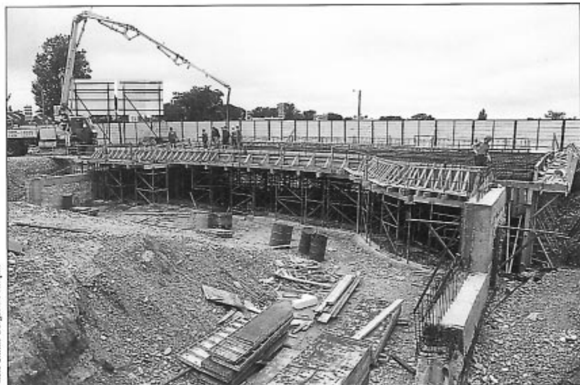
Bétonnage de la dalle en cours (noter l'étalement au sol, y compris de la charpente).
