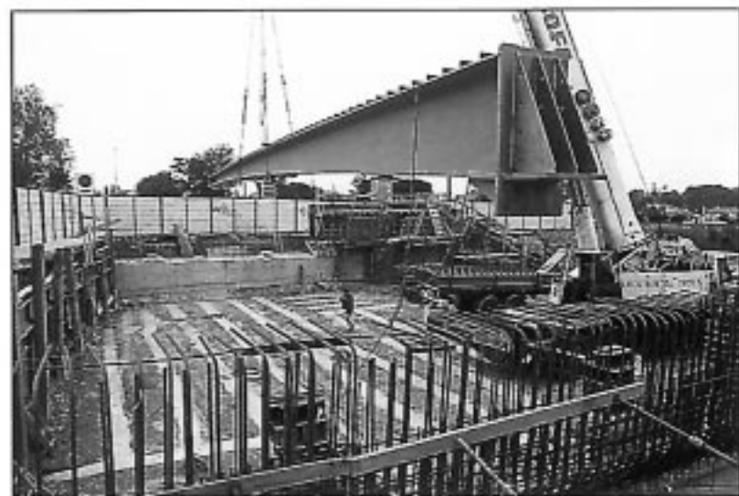
Pose des poutres principales (noter la conception de la charpente côté encastrement).
