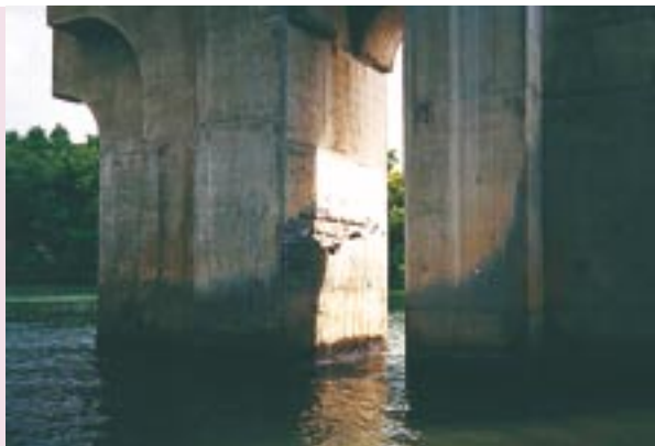
Photo 3 : dégradation de la pile P_2
