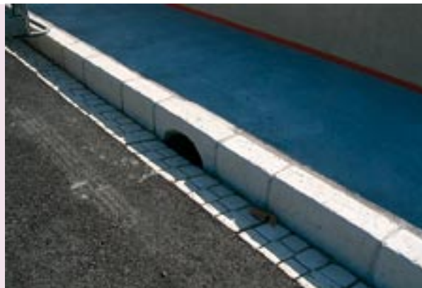
Bord de trottoir, chaussée terminée, revêtement de trottoir à réaliser
