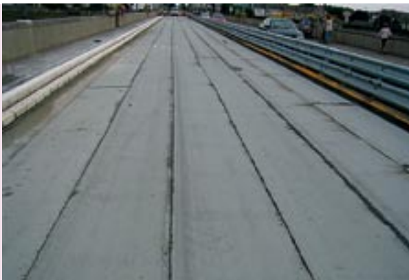
Etanchéité sur un demi-ouvrage
