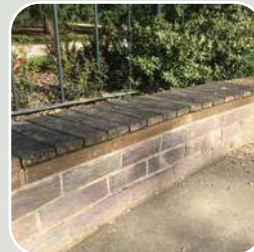
Banc pour attendre les enfants sur un parvis / bois sur la face supérieure du muret réduit à 45cm de haut
