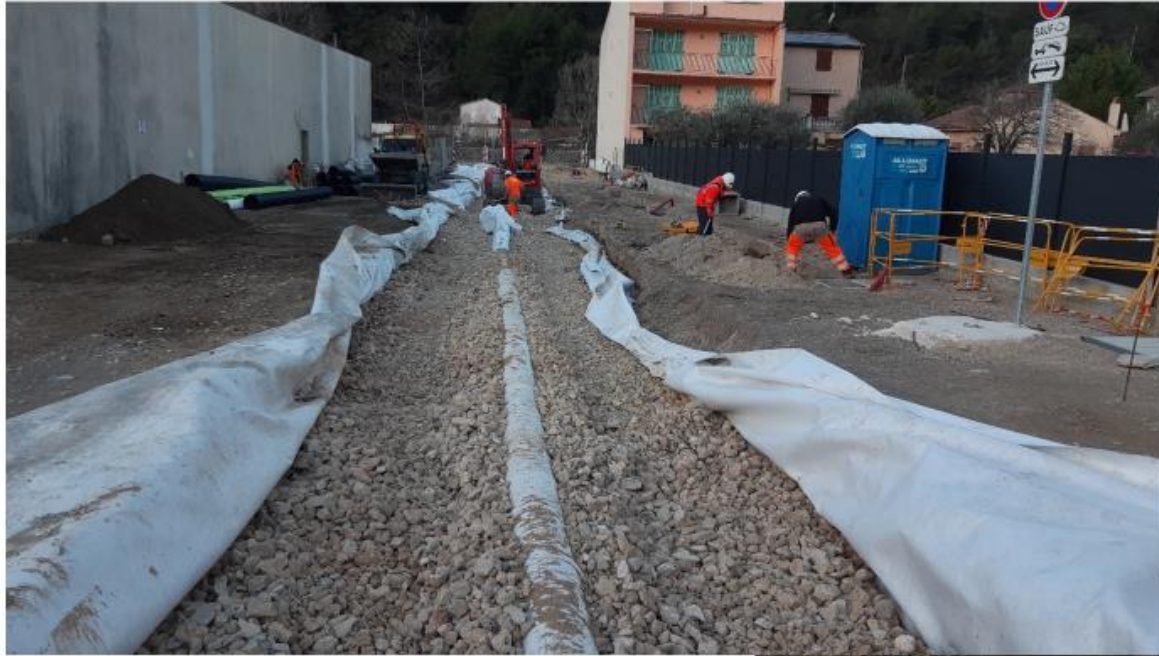
Mise en place d'un drain routier Ø300
