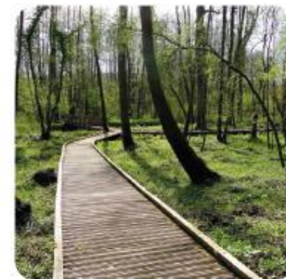
Bordures bois de guidage pour les platelages
